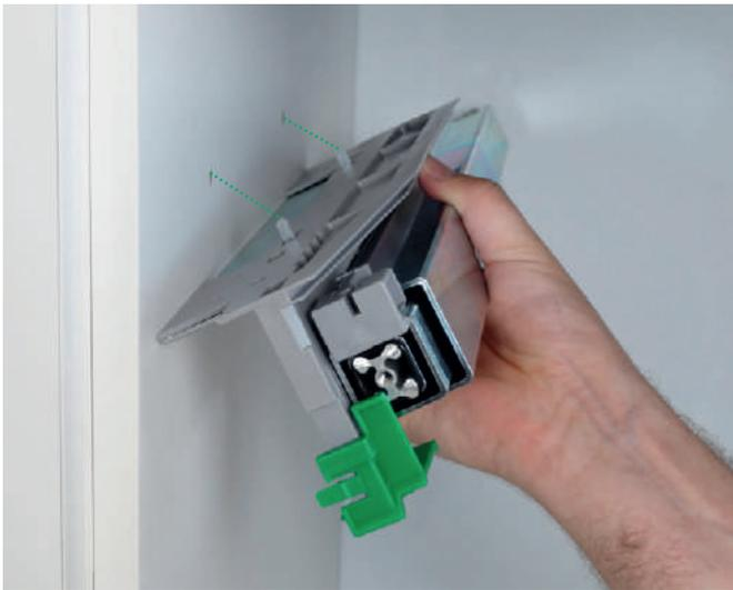
Installer la ferrure – les pattes de fixation maintiennent la ferrure en place...
